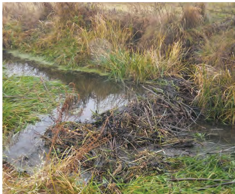
Zapora zbudowana przez bobry w zaniedbanym rowie melioracyjnym
